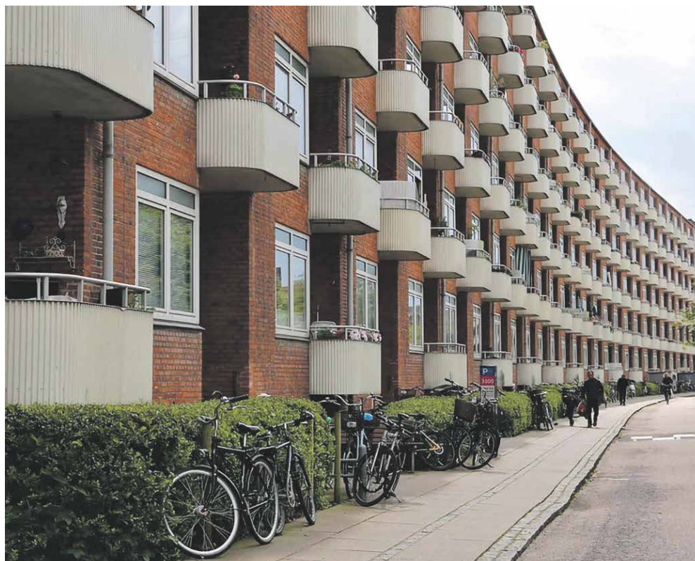
Renoveringen af Store Møllevej påbegyndes i juli.
